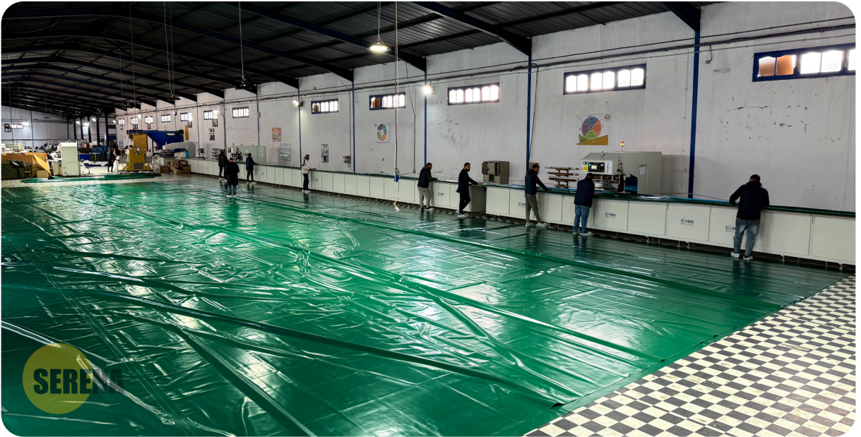
Herstellung eines 1000 m 3 Tanks
